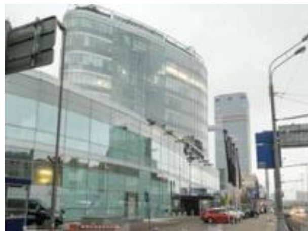
Фото 2. Внешний вид здания и окружающей застройки
