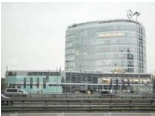
Фото 1. Внешний вид здания
