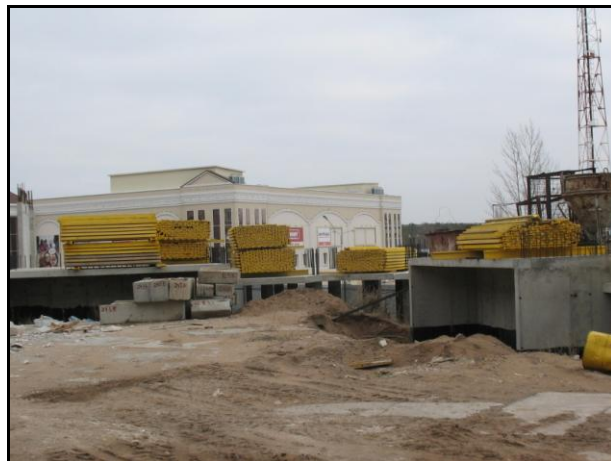
Фото 2. Внешний вид площадки строительства
