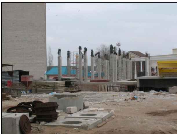
Фото 1. Внешний вид площадки строительства
