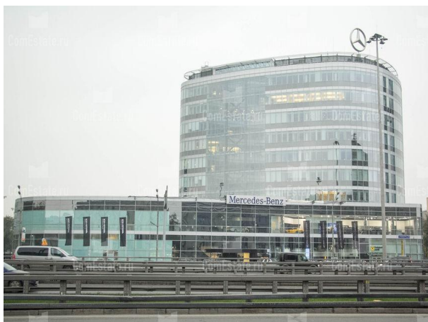
Фото 1. Внешний вид здания
