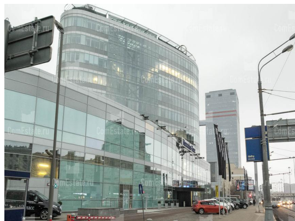
Фото 2. Внешний вид здания и окружающей застройки
